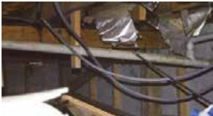
Loose wiring
